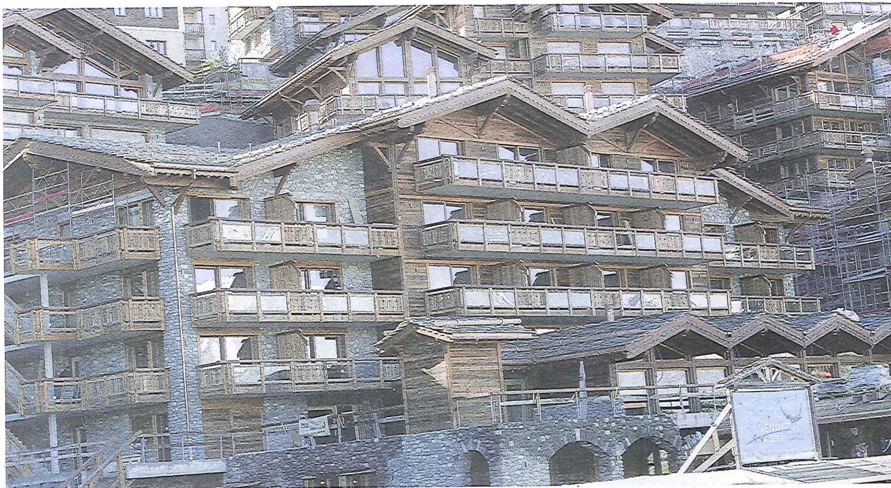
L'Hôtel Nendaz 4 Vallées, qui se situe au cœur du complexe Mer de Glace, a nécessité un investissement chiffré à 36 millions de francs BITTEL
