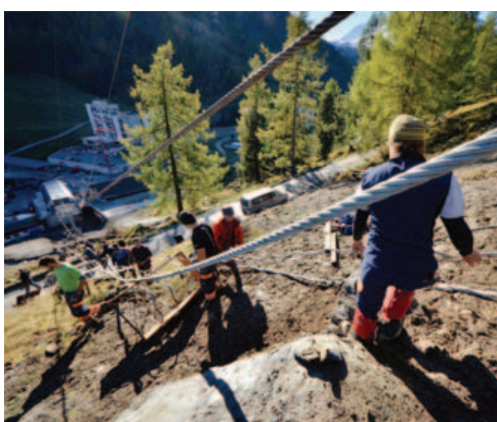
A coups de masse, le spécialiste ajuste les brins du câble de la télécabine. LE NOUVELLISTE
