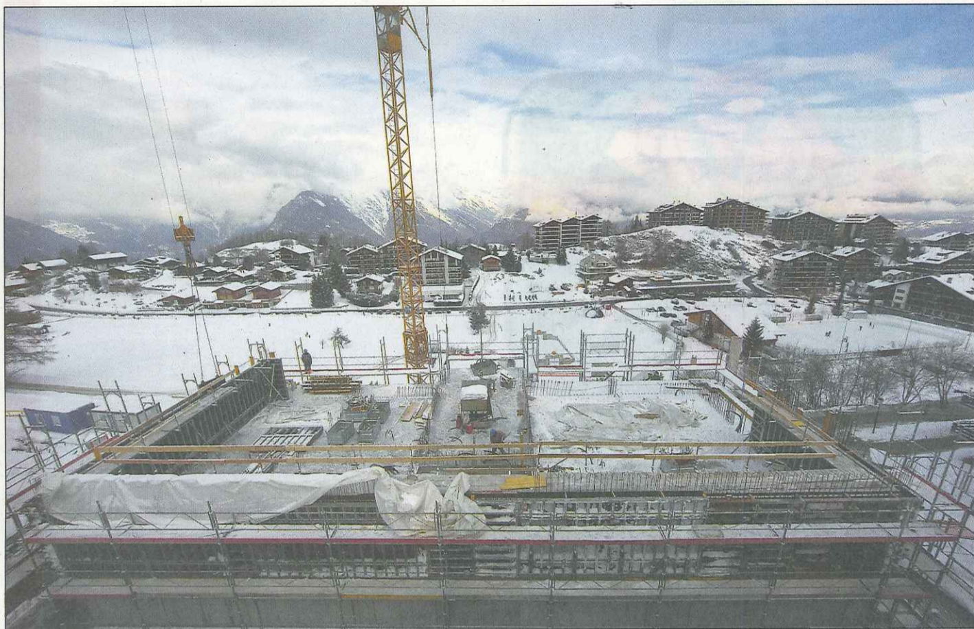
Le projet Mer de Glace sort de terre. Trois chalets sont terminés et le second-œuvre va bientôt débiter dans la partie hôtelière.
